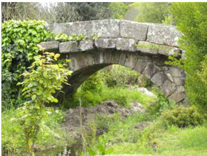
| Ponte de Augapesada
