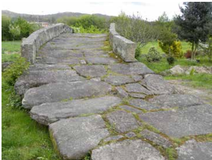
Ponte de Augapesada |
