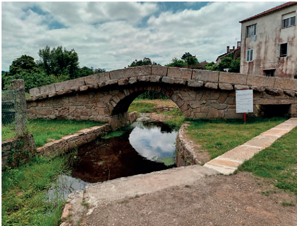
Fig. 1. Ponte de Augapesada (Ames). Foto: Xosé M. a Lema
